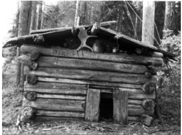
Рис. 2. Нижняя половина сруба сложена из бревен «в погон». Промысловая избушка, срубленная в начале XX века (до 1929 года) в лесу на берегу оз. Светлого неподалеку от деревни Келкозеро, Пудожский район Карелии. (Архив НИИНаЗ, 1991 года)
