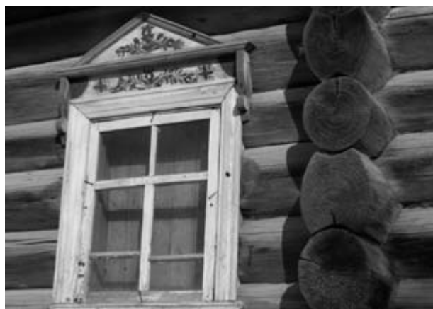
Рис. 4. Рубка стен «в разнопаз» (двойная припазовка отчетливо видна на торцах бревен). Фрагмент сруба дома-комплекса в д. Враниковская Плесецкого района Архангельской области. Фото А. Ю. Косенкова, 2009 год
