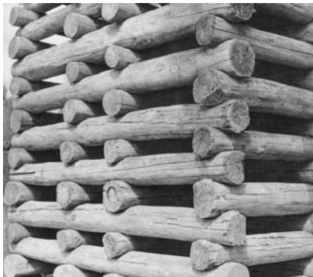
Рис. 3. Режевое основание мельницы из села Азополье Мезенского района Архангельской области [15; 205]
