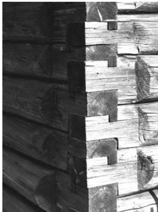
Рис. 6. Угол избы, рубленный «в крюковую лапу». Деревня Юшкозеро Калевальского района Карелии. Фото А. Ю. Косенкова, 2007 год
