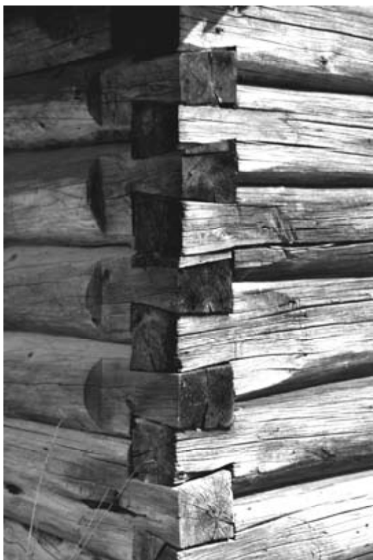
Рис. 5. Рубленный «в косую лапу» угол сней церкви прп. Александра Свирского в д. Космозеро Медвежьего района Карелии. Фото А. Ю. Косенкова, 2010 год
