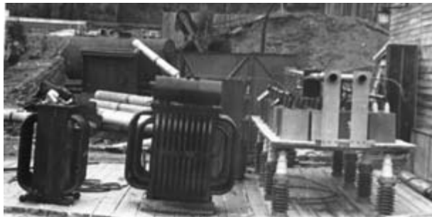
Рис. 2. Установка для раскрытия сростков слюды (в процессе монтажа), на переднем плане – зарядное устройство АИФ-400
