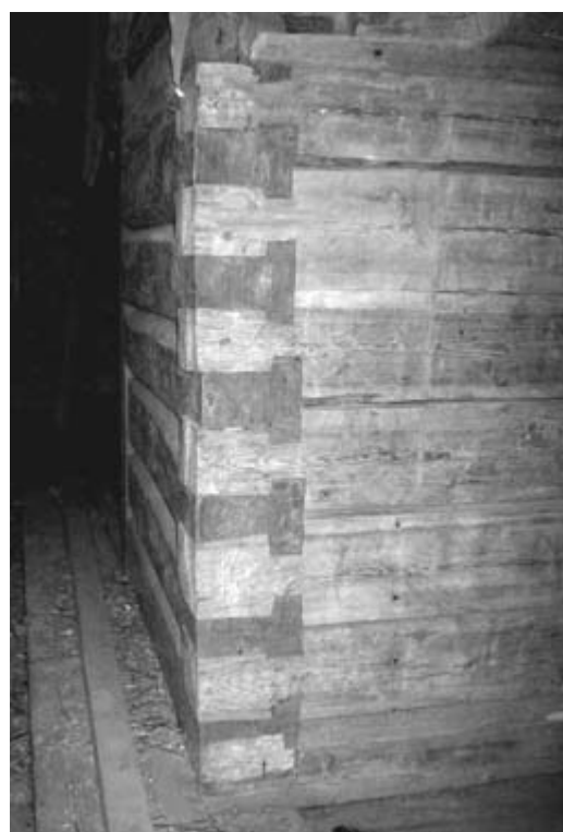
Рис. 7. Угловая врубка в прямоугольную «лапу» с двумя коренными шипами на всю длину соединения. Владимирская церковь в с. Подпорожье (Жеребцова Гора) Онежского района Архангельской области. Фото из архива сайта «Онега-Онлайн»
