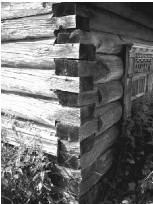
Рис. 4. Угол избы, рубленный «в простую лапу». Деревня Гужово Каргопольского района Архангельской области. Фото А. Ю. Косенкова, 2009 год
