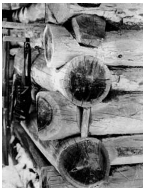
Рис. 3. Угол сруба промыслово-охотничьего стана на Лешозере в Карелии, сложенного «в погон». По месту использовано дополнительное укрепление углового соединения бревен деревянным штырем-упором [12; 234]
