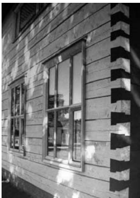
Рис. 8. Угол жилого дома, рубленный «в косую лапу» с коренным шипом на всю длину соединения. Швеция. Фото Финна Йенсона.
