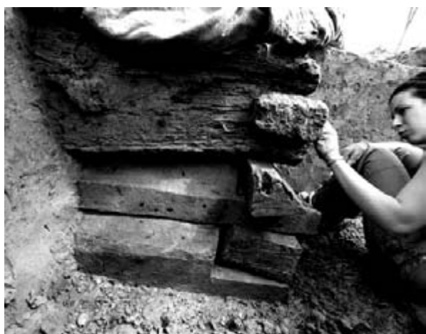
Рис. 1. «Протосруб» с соединением в углах стенообразующих элементов «в полдерева», раскопанный итальянскими археологами в провинции Лукка в Тоскане.
