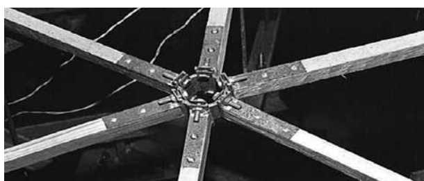
Рис. 2. Узел соединения ребер купола
