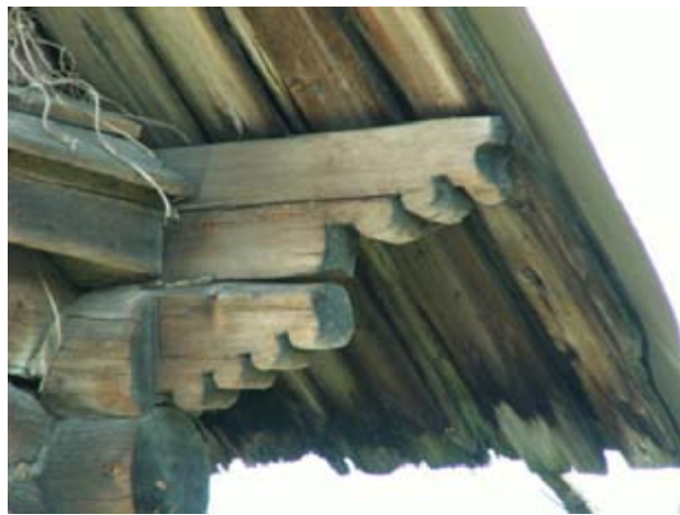
Подкрышные кронштейны в деревне Дуброво. Фото А. Косенкова
