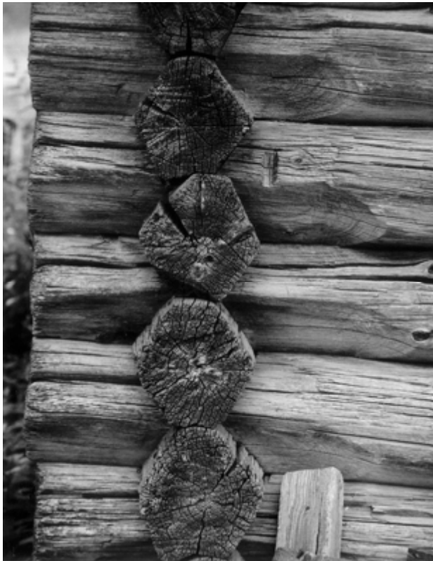
Рис. 3. Шестигранная обработка концов бревен («шведский угол») амбара в д. Шульгино (фото И. Е. Гришиной, 2004 г.)
