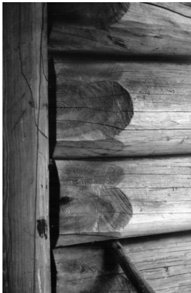
Рис. 11. Трехчастная подтепка бревен стены в месте сопряжения с косяками дверного проема (часовня в Коростелёво).
