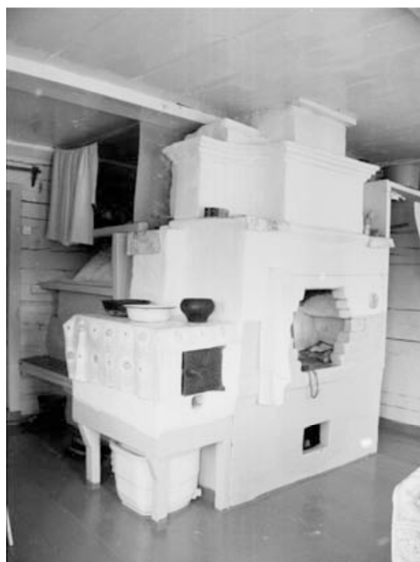
Рис. 5. Печь с «бочкой» и деревянным настилом лежанки в доме М. В. Коноваловой, с. Гридино
