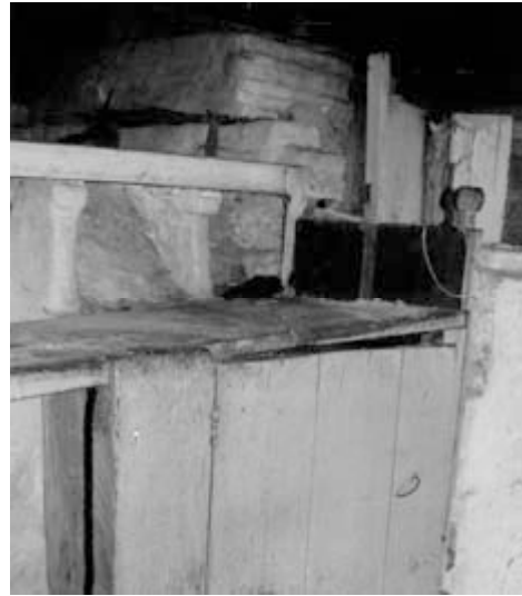
Рис. 7. Печь с кирпичными устоями на скате полубочки, д. Воренжа
