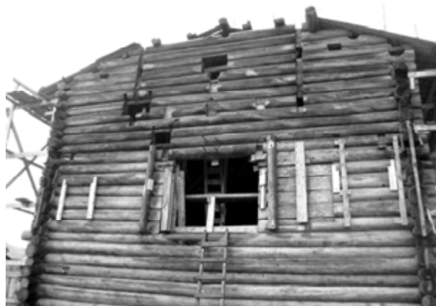
Рис. 5. Западная стена трапезной со следами реконструкций, проемом для дымника. Фото В. А. Титова
