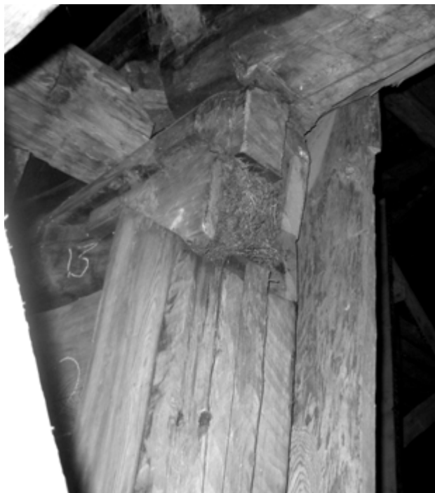
Рис. 4. Остаток первоначального косяка двери в трапезную. Фото Т. И. Вахрамеевой
