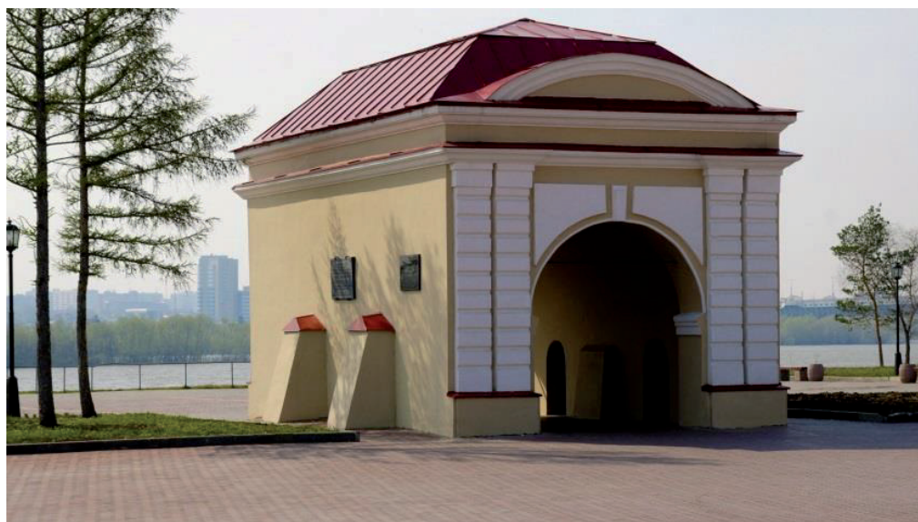
Илл. 37–38. Тобольские ворота — до (1965) и после реконструкции Fig. 37–38. Tobolsk Gate — before (1965) and after reconstruction
