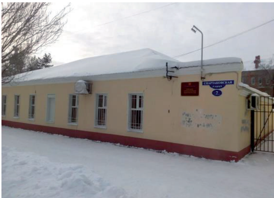
Илл. 17. Дом настоятелей омского Воскресенского собора (современный вид) Fig. 17. The house of the rectors of the Omsk Resurrection Cathedral (modern view)
