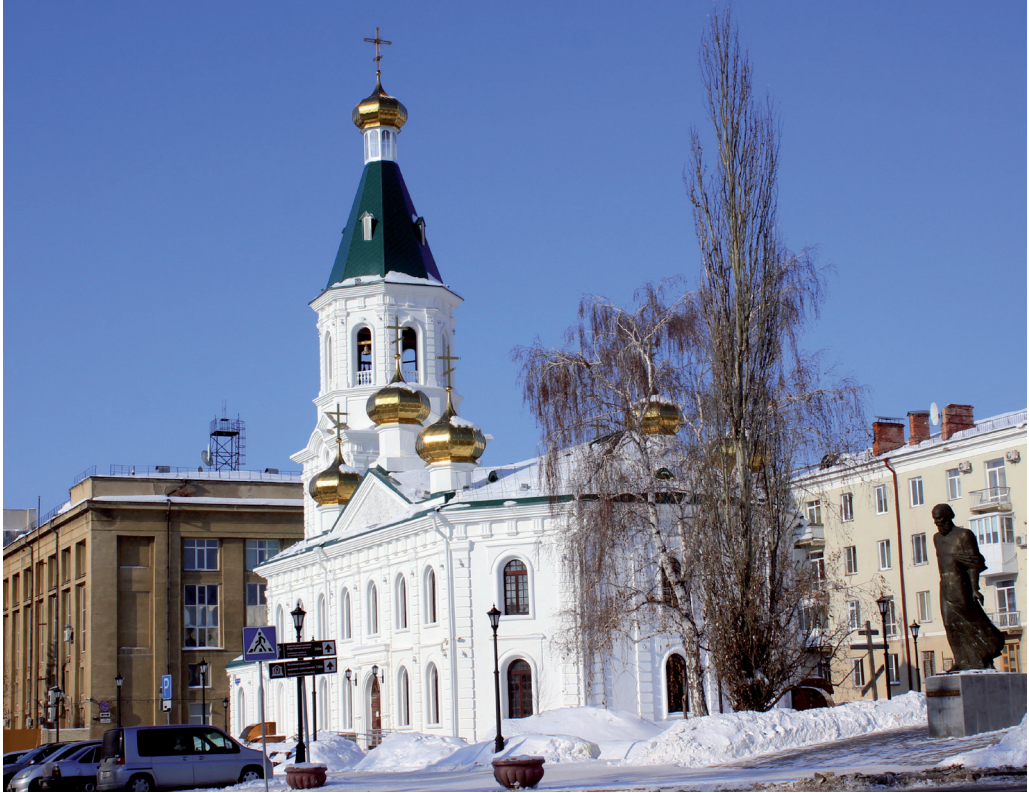
Илл. 42. Воскресенский собор в Омске после реконструкции (2024)
