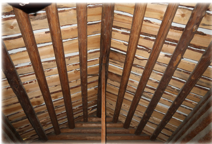
Рис. 3. Восточный фронтон и конструкции крыши изнутри (фото 2022 г.)
