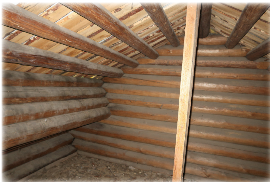
Рис. 4. Фрагмент фронтона, слег и стенки между северными скатами (фото 2022 г.)
