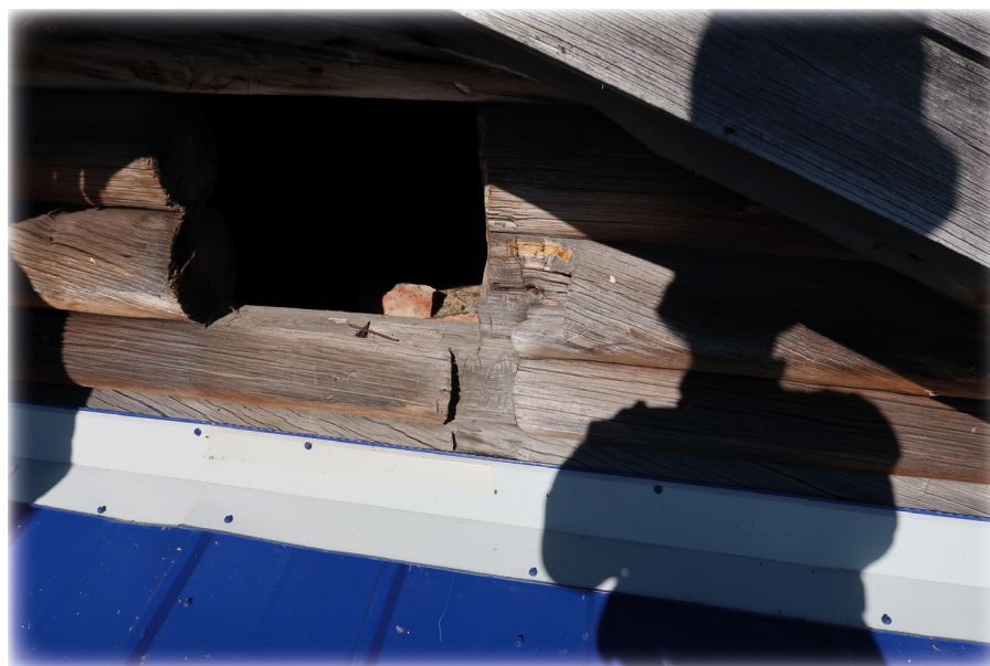
5. Западный фронтон притвора со следом от коневой слегой крыши крыльца (фото 2022 г.)
