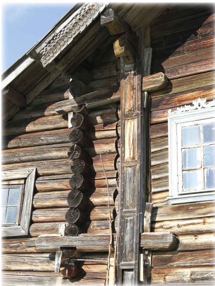
Соединение срубов на западном фасаде с помощью бревенчатых замков, дом Абрамовых
