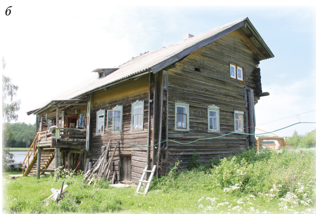
Дом Абрамовых в дер. Сычи: а — лицевой фасад; б — вид с юго-востока
