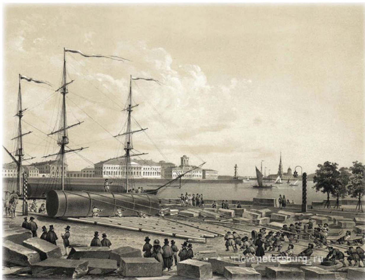
Выгрузка и перекачка колон. Литография с рисунка О. Монферрана. [73: 180]
