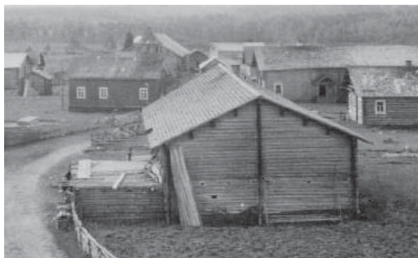
Рис. 12. Щипцы с семью перерубами. Вверху – д. Палоярви Питкярантского района РК, 1928 г. (фото Е. Leskinen). Внизу – д. Кауноселкя Питкярантского района РК (фото Raija Eevala)
