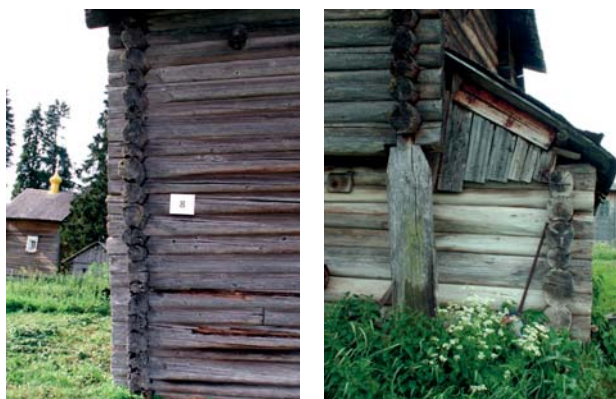
Рис. 4. Конструкция озадков хозяйственных частей домов-комплексов (фото автора): слева - единая срубная конструкция, д. Кинерма, 2012 г.; справа - озадок на столбах, д. Кургеницы (Заонежье), 2007 г.
