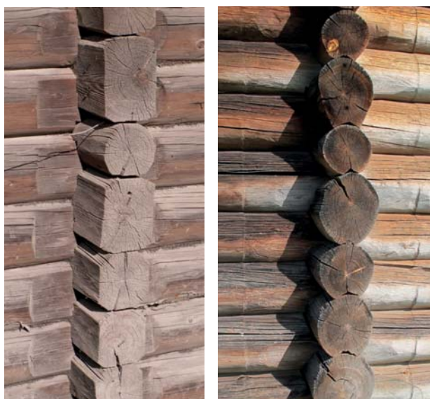
Рис. 7. Упорядоченная подтеска бревен в местах соединения.
