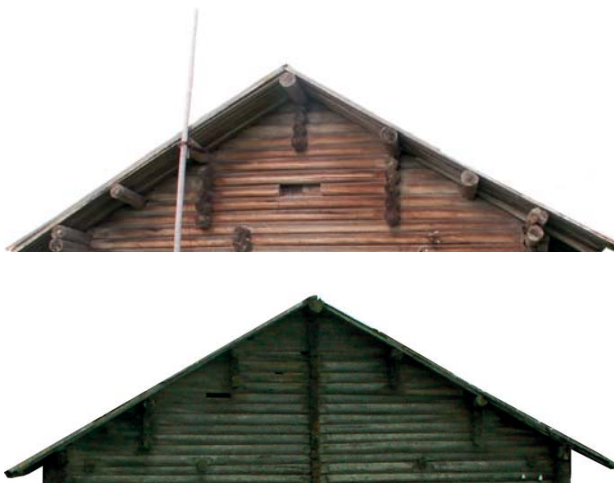
Рис. 11. Щипцы самцово-сlegовых крыш: с тремя (вверху) и пятью (внизу) перерубами.
